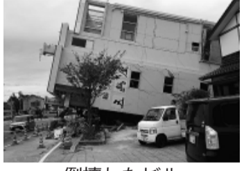
倒壊したビル
